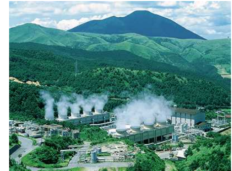
八丁原地熱発電所(九州電力)
